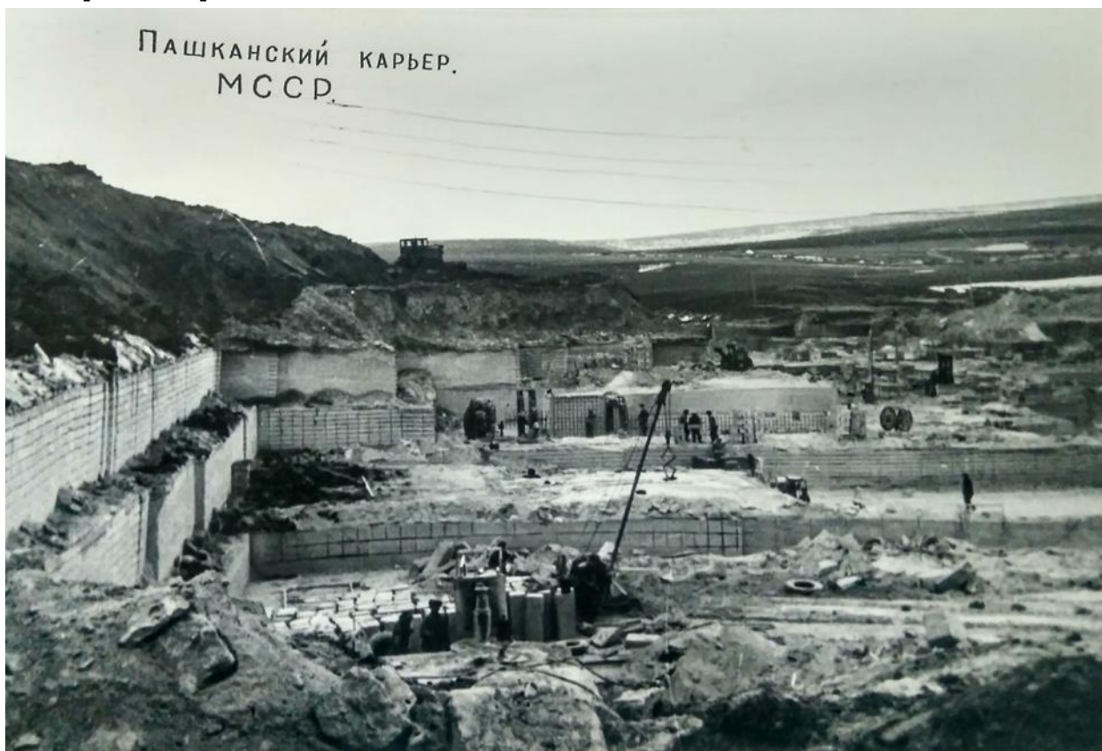
Fig. 2.1. Extragerea cotilețului. Cariera Pașcani [ANA,DFASP]
