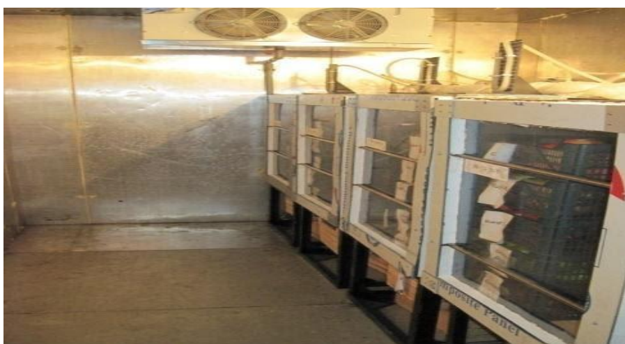
Figura 2.8. Boxele utilizate pentru păstrarea fructelor în condiții cu AC (boxe frigorifice închise ermetic) (Sursa foto: autorul tezei)
