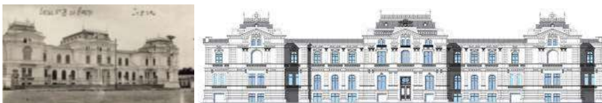
Figura 2. 41. Gimnaziul de băieți nr. 3 (astăzi AMTAP), arhitect V. Țâganco, 1905, or. Chișinău [533]
