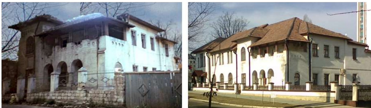
Figura 3.23. Vila urbană din strada Sfatul Țării, or. Chișinău [530]
