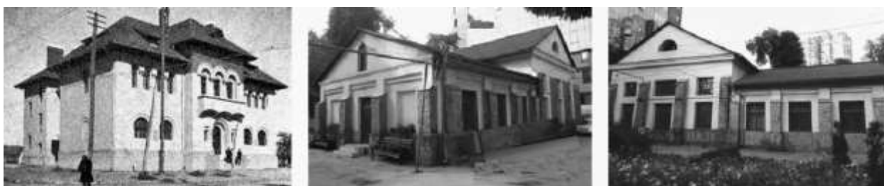
Figura 3.3. Căminul de ucenici ai feroviarilor, Uzina de Apă, Chișinău, 1929 [520]
