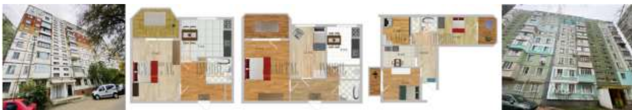
Figura 5.2. Blocuri de apartamente din seria 135 din RSS Moldovenească și Republica Moldova [533]
