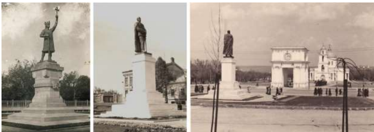
Figura A 5.2. Ștefan Cel Mare, Chișinău, 1928; Monumentul Regelui Ferdinand I, Chișinău, 1939, Al. Plămădeală [535]
