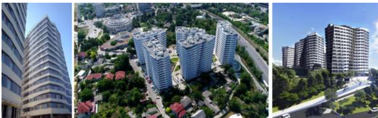
Figura A 9.3. Edificii arhitectonice bionice din or. Chișinău [538]
