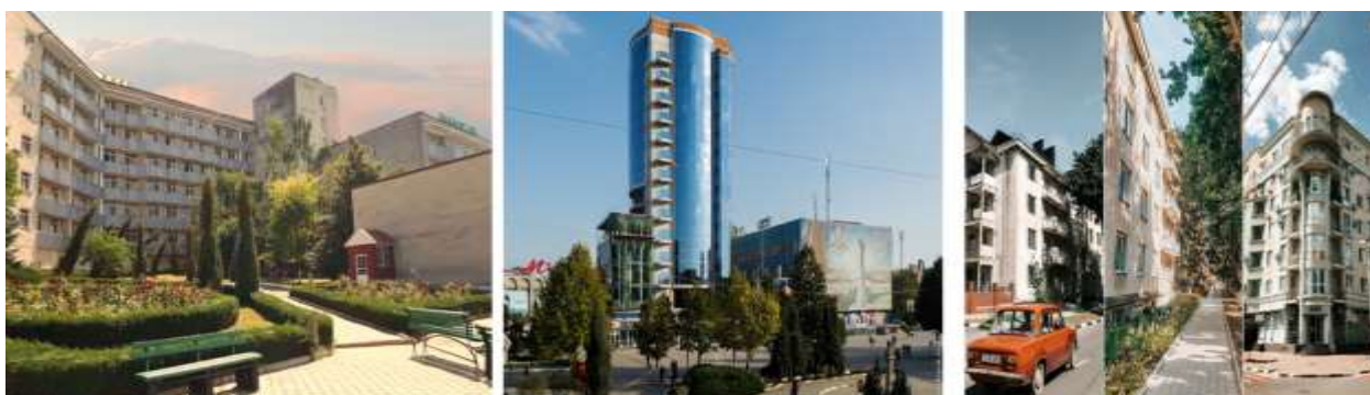
Figura A 8. 9. Construcțiile-turnuri, incluse în arhitectura contemporană din Republica Moldova [538]
