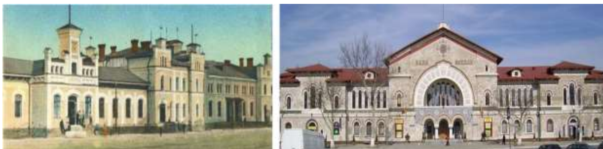
Figura 4.3. Gara feroviară (1871), arhitect H. Lonski și sediul nou (1948), arhitecți A. Șciusev și L. Ciuprin, or. Chișinău [533]
