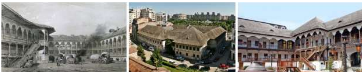
Figura 2.29. Hanul Manuc-Bey, București (1806-1808), unde a fost semnat Tratatul din 1812 de ocupare a teritoriului Principatului Moldovei dintre Prut și Nistru de către Imperiul Rus [148]
