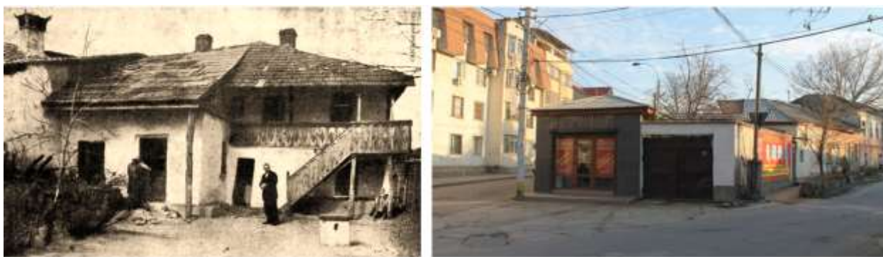
Figura 2.17. Casa Mani-Jelescu, imagine din spatele casei, or. Chișinău, 1920; Astăzi din Casa Mani-Jelescu, astăzi a mai rămas o parte din blocul 3, 2000 [300; 513]
