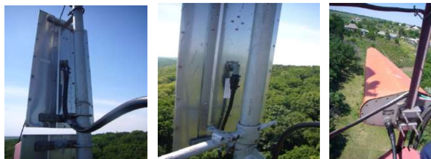
Fig. 2.26. Aspectul exterior al antenelor TVA 31/50 (în stânga), TVA 51/50 (în centru) și LAP 4/5-50/16 (în dreapta)
