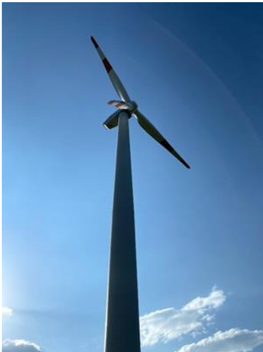
Fig. 5.1. Turbină eoliană cu ax orizontal din s. Trușeni, mun. Chișinău Sursa: foto original
